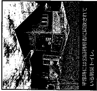
大災害など非常時には、排泄物は汚水槽に貯められる。また、排水時の水は地下水を汲み上げる仕組みだ。地下水は、生活用水にもあてられる。
