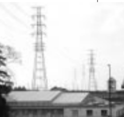
電磁波の人体への影響が懸念されている。高圧送電線が敷地内を横断する根郷中学校
