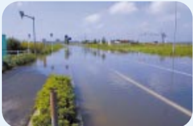
昨年の水害で冠水した幹線道路 (国道296バイパス：寺崎地先)
