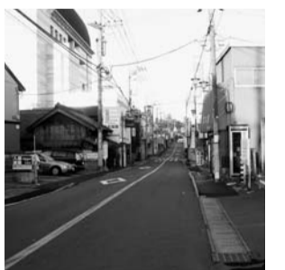
無電柱化整備予定の旧国道296号（新町地先）
