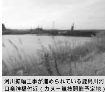
河川拡幅工事が進められている鹿島川河口竜神橋付近(カヌー競技開催予定地)
