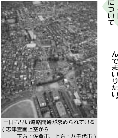
一日も早い道路開通が求められている (志津霊園上空から) 下方: 佐倉市、上方: 八千代市
