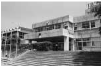
長期的視野で、研究機関等から十分情報を得ながらアスベスト対策を（建物調査が行われた学校施設）
