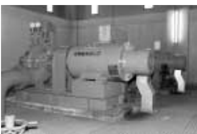
アスベストの現地調査が行われた水道施設（南部浄水場）
