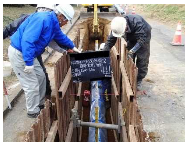
水道工事の様子
